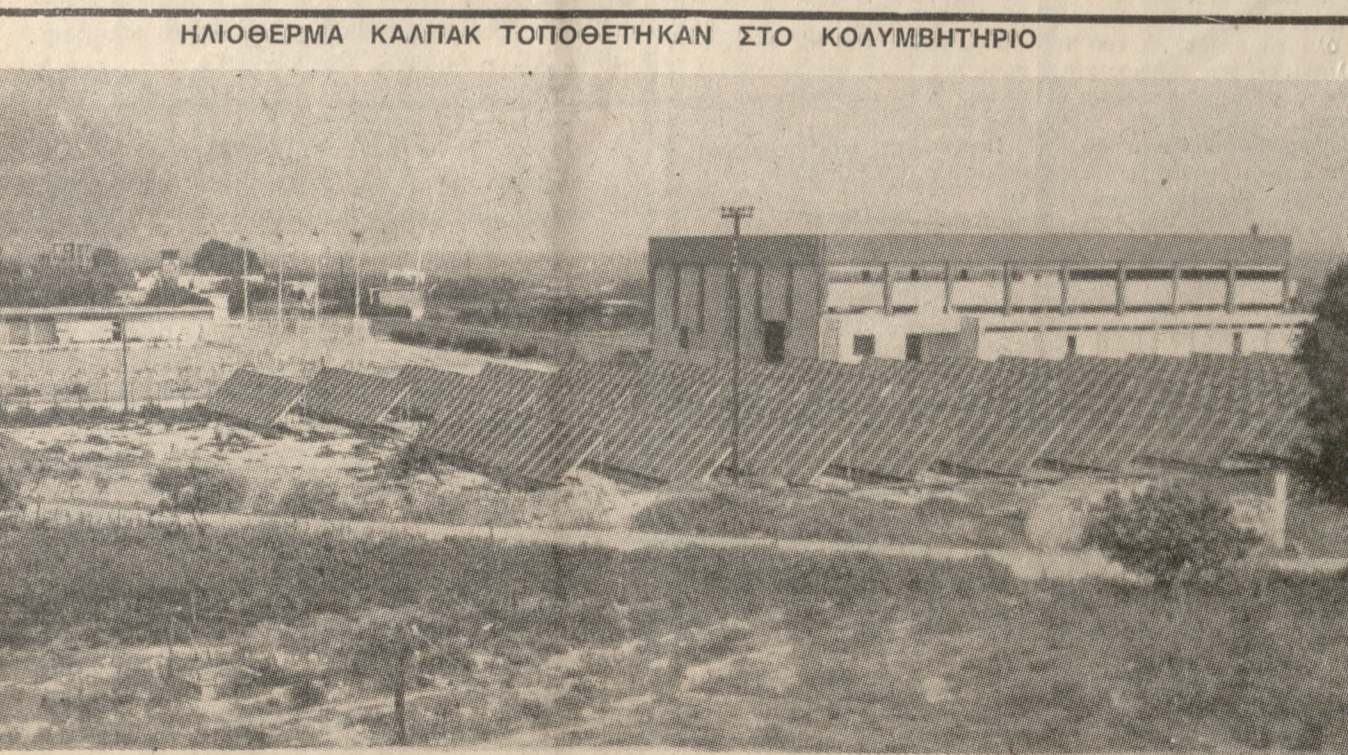
Ηλιοθερμα ΚΑΛΠΑΚ τοποθετήθηκαν (φωτογραφία) στο Κολυμβητήριο του Ηρακλείου και εξασφάλισαν ζεστό νερό στην πόλη...
