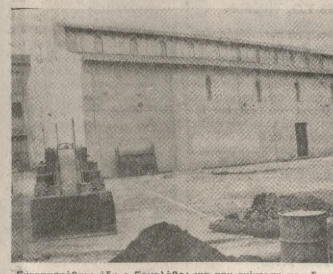
Εγκαταστάθηκε ήδη ο Εργολάβος για την ανέγερση του δημοτικού κτιρίου της οδού Ανδρόγεω. Χθες άρχισαν οι πρώτες εντατικές εργασίες. Εξάλλου χθες το απόγευμα ο βουλευτής κ. Κ. Ασάλης αναχώρησε για την Αθήνα όπου αναμένεται να έχει επαφές με την υπουργό Πολιτισμού και άλλους αρμόδιους κυβερνητικούς παράγοντες, προκειμένου να πετύχει το σταμάτημα των εργασιών. (Φωτογ.: Νικ. Μαλτεζάκης Γιαννιτών 19, Τηλ. 285261).
