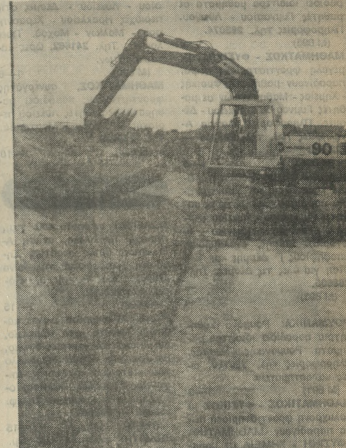
Κατασκευή έργου από την ΔΕΥΑΗ στην περιοχή του Πανασιππιλάκου Νοσοκομίου.
