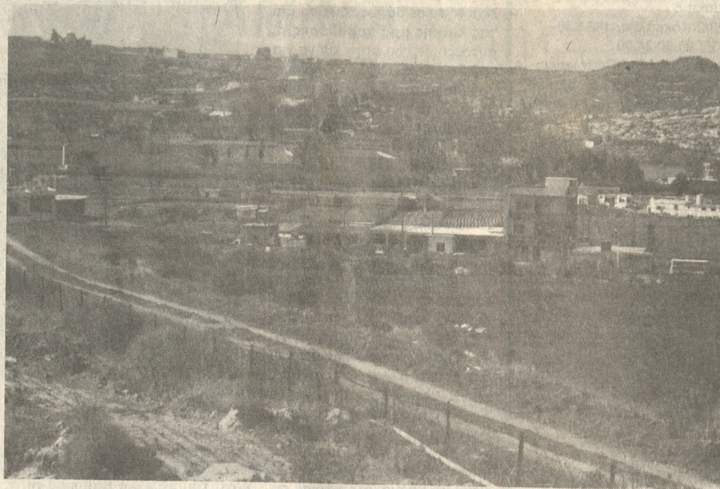
Ο χώρος που θα γίνει το εργοστάσιο της λιπασματοποίησης.
