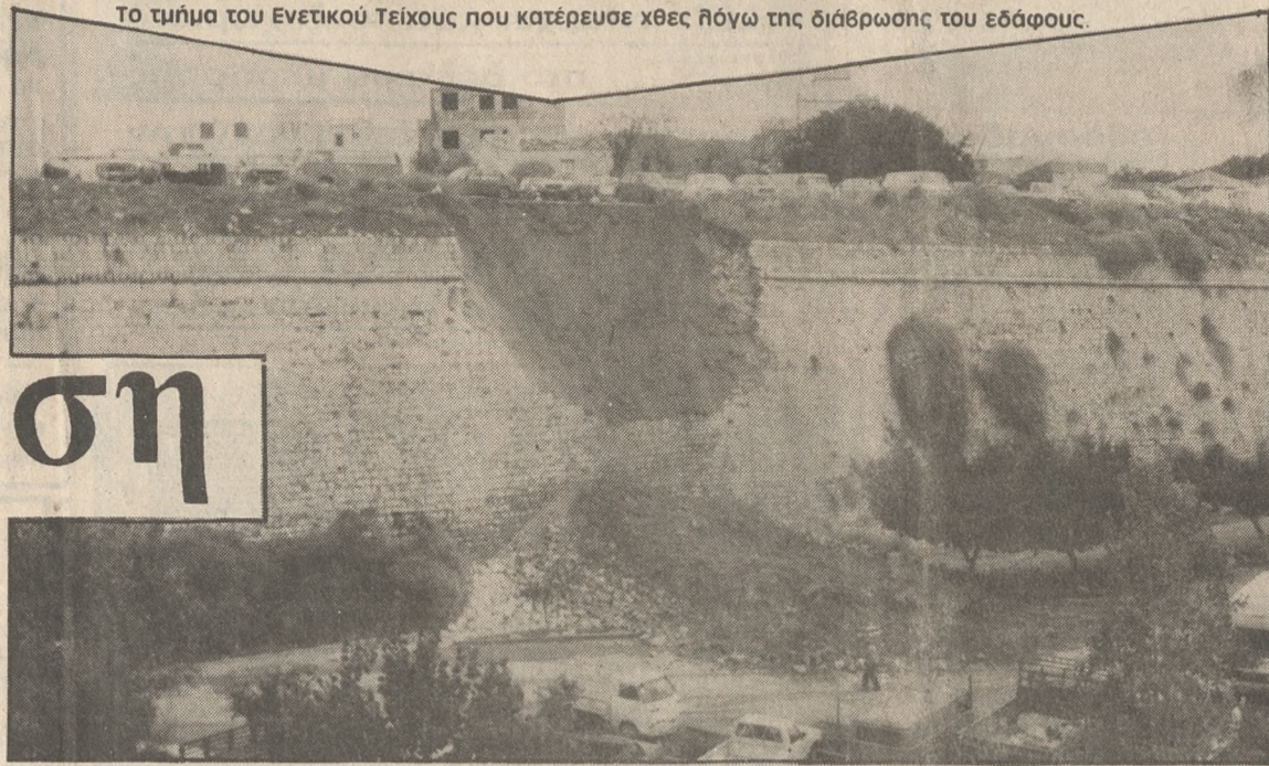
Το τμήμα του Ενετικού Τείχους που κατέρρευσε χθες λόγω της διάβρωσης του εδάφους.
