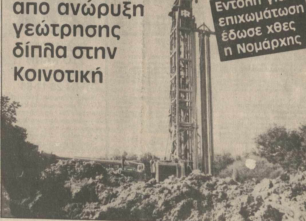
Το γεωτρήσανο εν ώρα εργασίας
