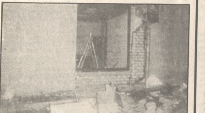
Γκρέμισαν και τοίχους στο πάραμα τους οι οπαδοί του ΟΦΗ. Η φωτογραφία είναι αμευδής μάρτυρας των ζημιών που προκάλεσαν οι ταραχές σε καταστήματα της πόλης τη Τετάρτη στο Ηράκλειο.
