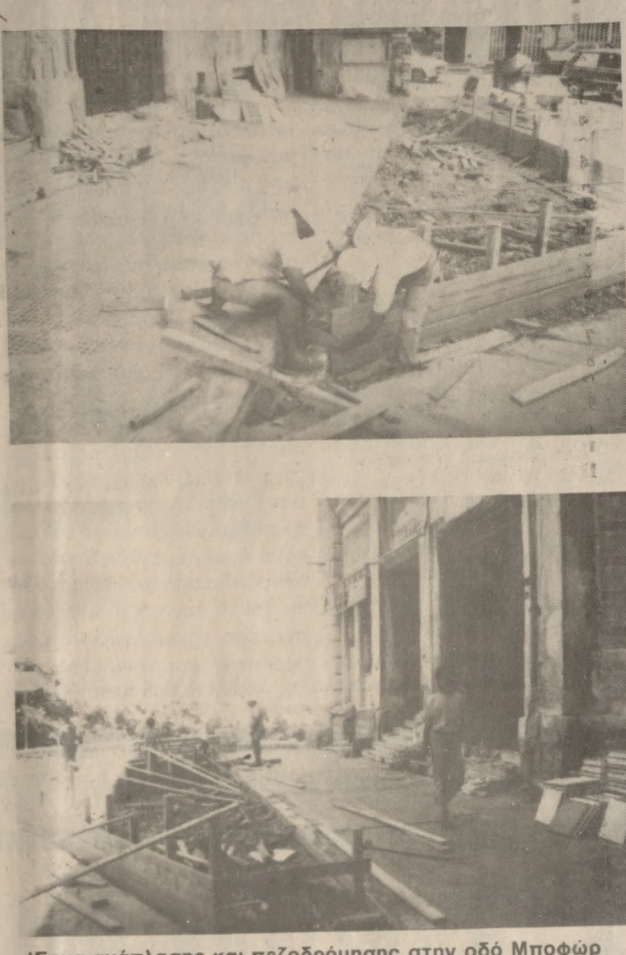
Έργα ανάπλασης και πεζοδρόμησης στην οδό Μποφόρ
