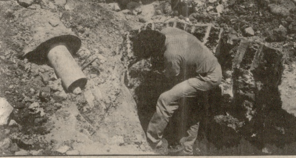
Επισκευή σπασμένου αγωγού
