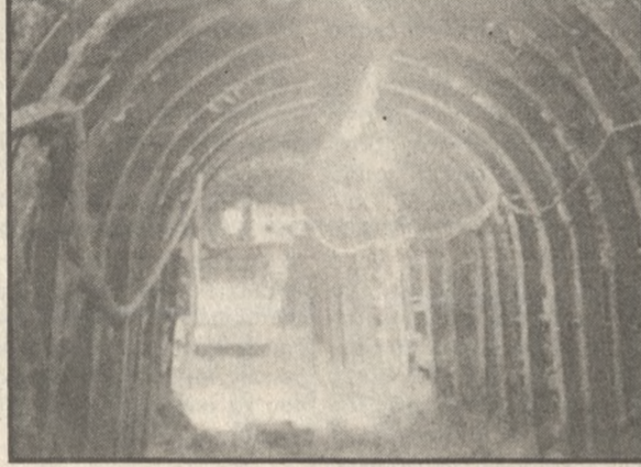
Διανοική σπράγγας για την κατασκευή του Κεντρικού Ανατολικού Αποχετευτικού Αγωγού
