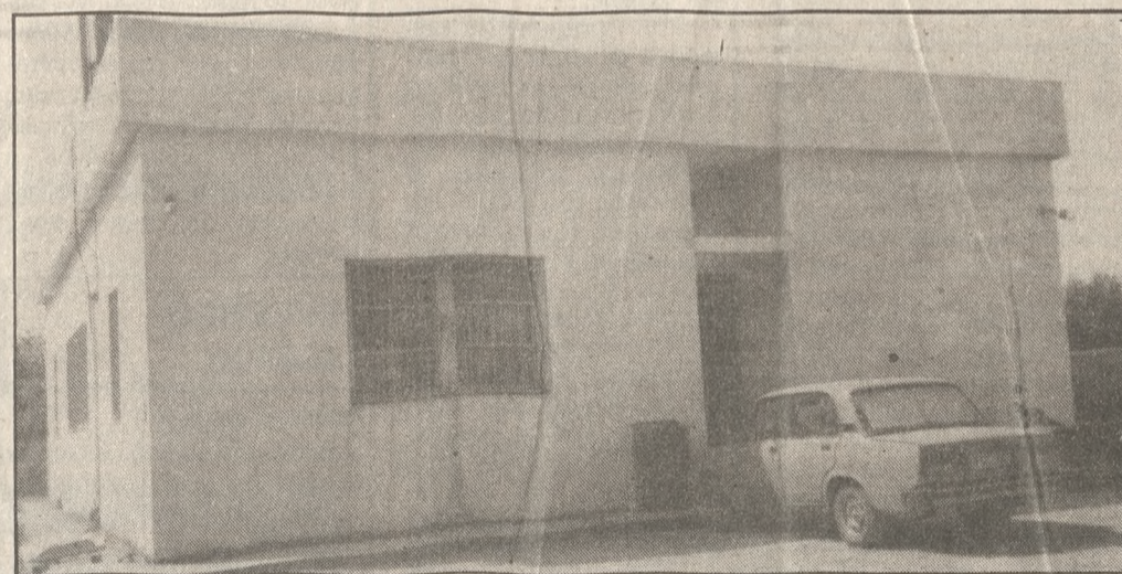
Ο Περιφερειακός Παράκτιος που εδρεύει στην περιοχή Εσταυρωμένων του Ηρακλείου
