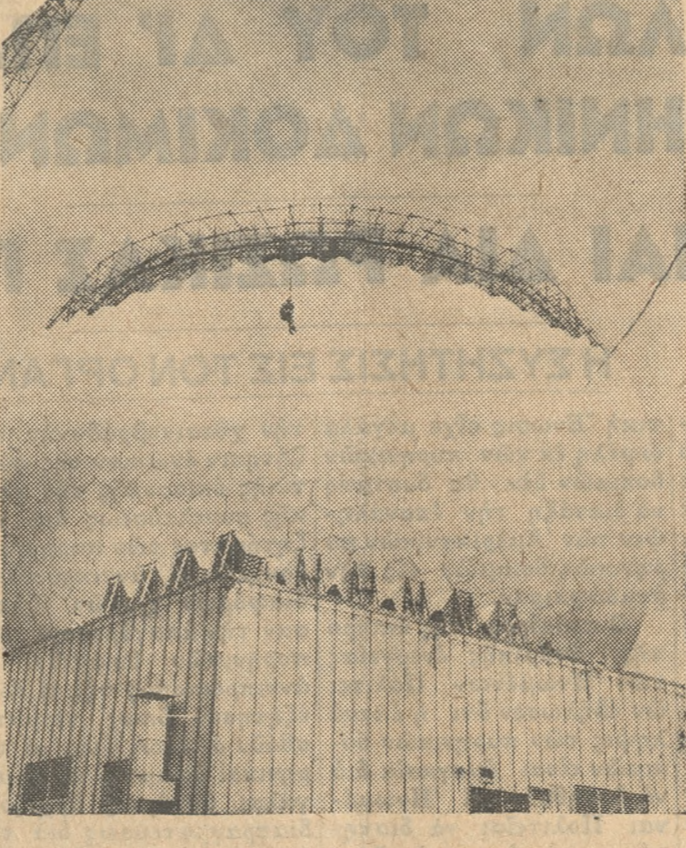
Ἐν γίγαντιον προστατευτικὸν περίβλημα διὰ συσκευῆς ραντάρ πού ἐγκαταστήθη εἰς τὴν Ἀρκτικὴν ὑπὸ τῆς Ἀμερικανικῆς Ἀεροπορίας, διὰ τὴν ἐγκαιρὴν πρόληψιν ἀεροναυτικῆς ἐπιβίβσεως. Ἐντὸς τοῦ περιβλήματος ὑπάρχουν ἀντέναιαι πού διὰ προστατεύονται ἀπὸ τὰς θύελλας. Τὸ περίβλημα εἶναι διαμέτρον 42 μέτρον καὶ ἀποτελεῖται ἀπὸ ἐξαγώνων πλάκας, ὑψηλότερας ἀπὸ ἀνθρώπου, ἀπὸ πεποιημένον χάρτιν ἐπενδεδυμένον μὲ ὑαλίνας ἴνας, ἐμβραπτισμένους εἰς πλαστικὴν ὕλην.
