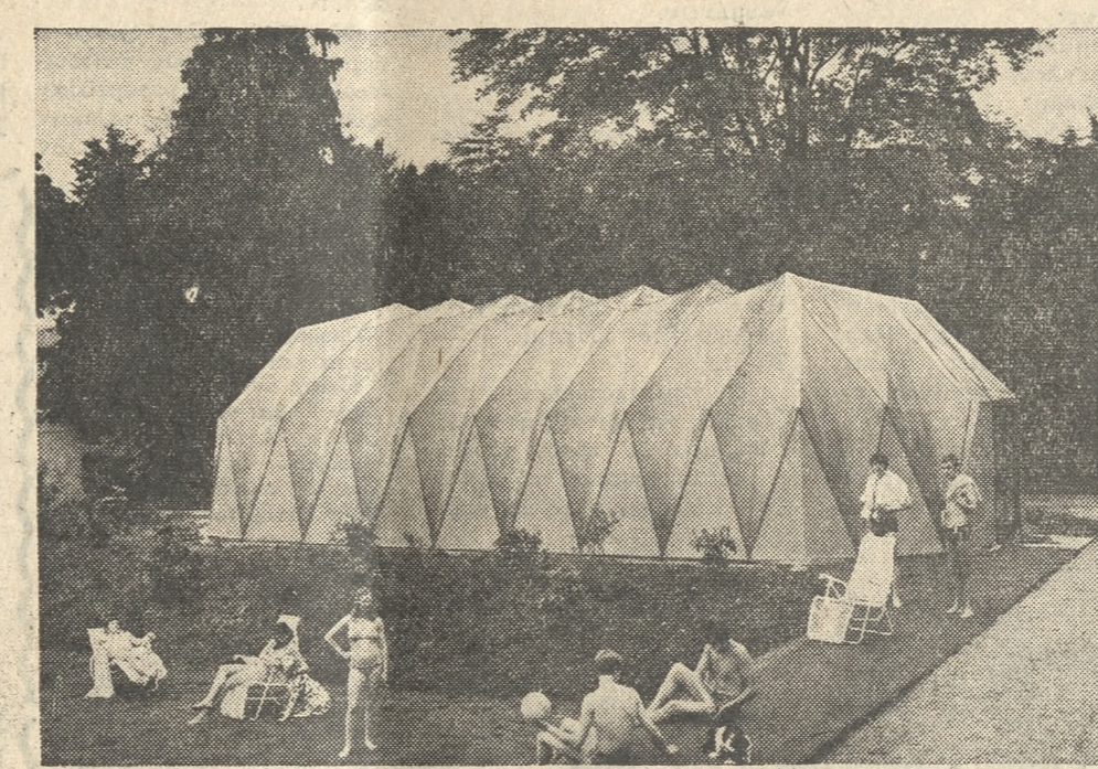
Το νέο αυτό αυτοστηριζόμενο κτίριο άπο πλαστικό ένισχυρό με ίνες ύδου καλύπτει μιά κολυμβητική δεξαμενή στα 'Αμπεριών της Σκωτίας και είναι το πρώτο ποδ άγειται σύμφωνα με μιά μέθοδο οικοδομησεως έξελιχθείσα στην Βρετανία. Έχει μήκος 50 ποδ., πλάτος 25 ποδ. και ύψος 13 ποδ. Το σχέδιο του είναι μοντέρνο και μοιάζει με τις έδρες του διαμαντιού. Αποτελείται άπο πολλά κομμάτια και άνηγέρη μέσα σε δύο ημέρες άπο τέσσερις εργάτες χωρίς να χρησιμοποίηθούν βαριά μηχανήματα.
