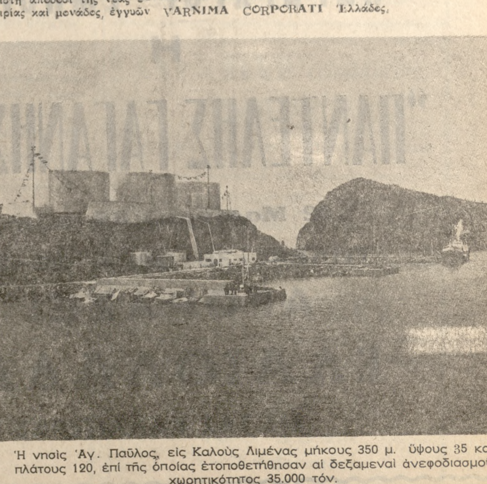
Η νησίς Άγ. Παύλος, εις Καλούς Λιμένες μήκους 350 μ. ύψους 35 καί πλάτους 120, επί τής όποιας έτοιμασθήσαν αι δεξαμεναι άνεφοδιασμού χωρητικότητος 35.000 τόν.
