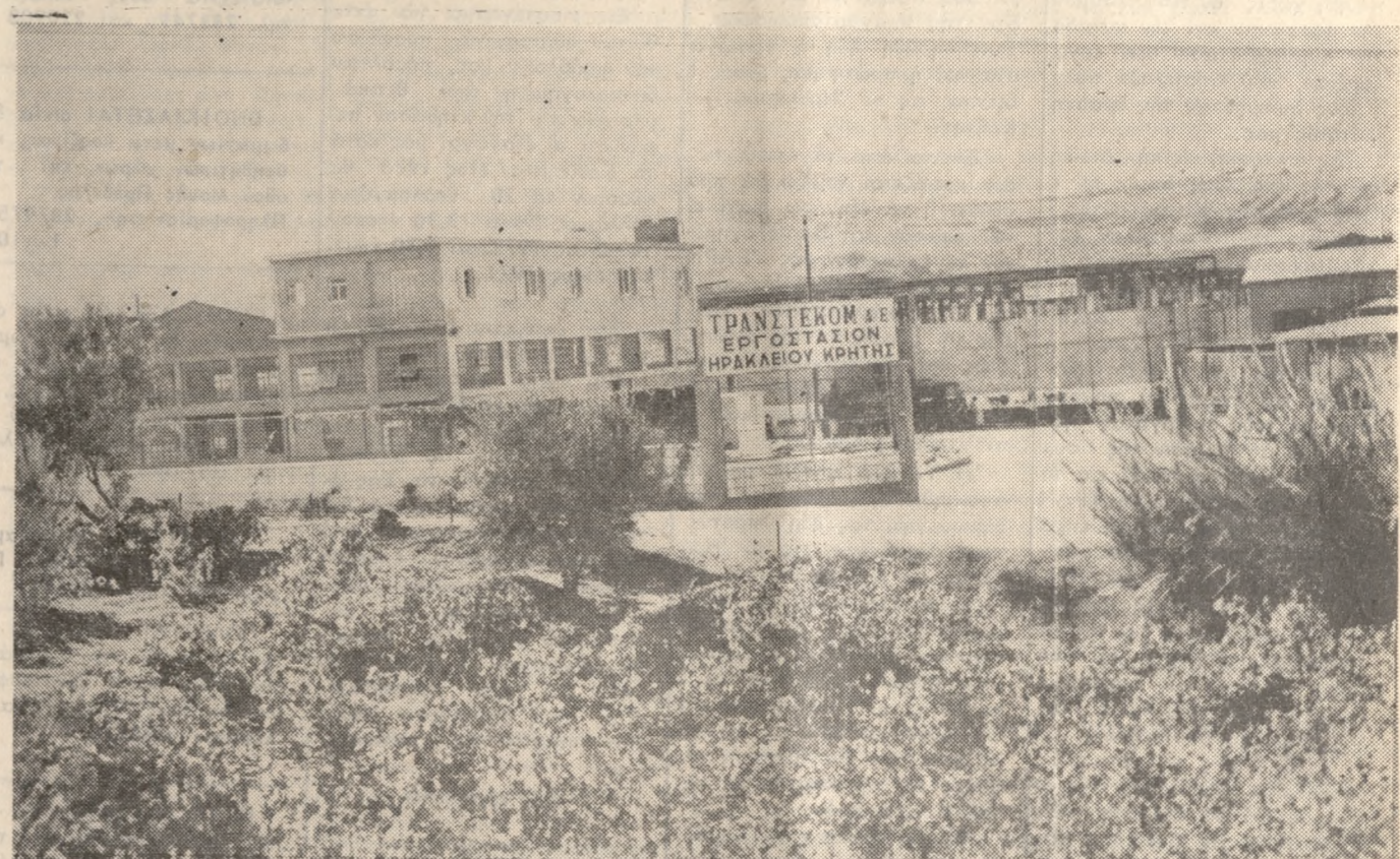
Ἡ πρόσοψη τοῦ σύγχρονου έργοστασίου τῆς «ΤΡΑΝΣΤΕΚΟΜ» στὴ Φοινικιά. Διακρίνονται (δεξιὰ) ἐπίσης καί οἱ τοιμεντένιες δεξαμενές κρασιοῦ.
