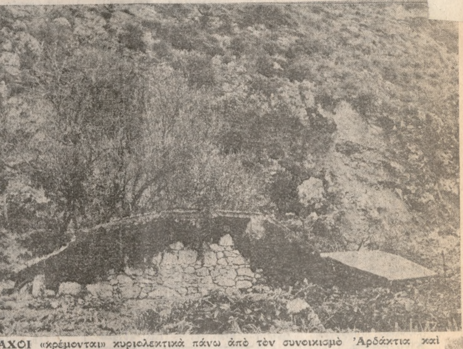
ΒΡΑΧΟΙ κρέμονται κυριολεκτικῶς πάνω ἀπὸ τὸν συνοικισμὸν Ἀρδάκτια καί ἀπελευθύνε τὰ σπῖτα. Μόνη λύση ἡ μεταφορά τοῦ συνοικισμοῦ σέ ἄλλο χῶρο.
