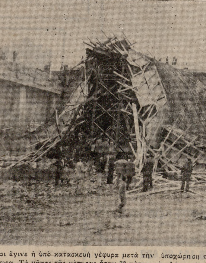
Έτσι έγινε ή υπό κατασκευή γέφυρα μετά τήν ύποχώρηση του σιδηρόστρου. Δίπλα διακρίνεται ή «όιδυμή» τής γέ-φυρας. Τό μήκος τής γέφυρας ήταν 30 μέτρα, τή πλάτος 11 και τό ύψος από τό έδαφος 20 μέτρα περίπου.
